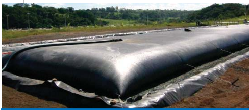
Fot. 1. Napelniona georura na polu drenażowym
