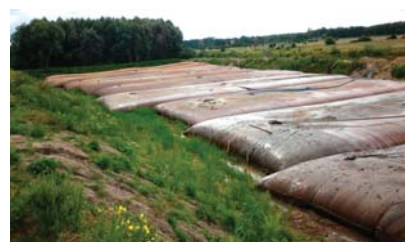
Fot. 4. Georury umieszczone w zagłębieniu
