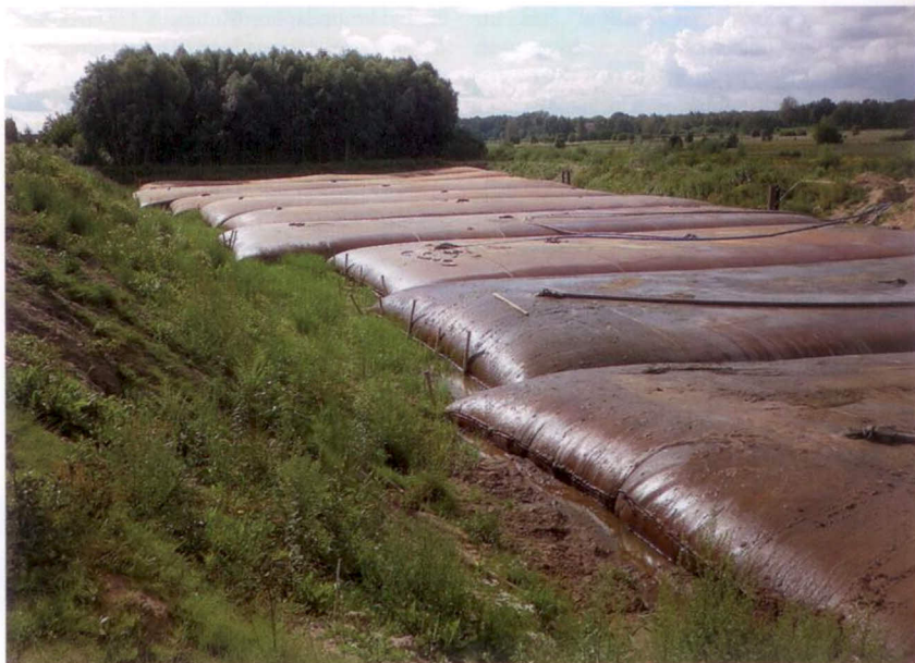
Napełnione geoury na polu drenażowym
