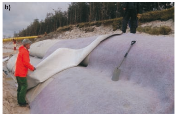
Rys. 13. Etap II: napelnianie drugiej georury mieszaniną wody i piasku (a) i zabezpieczenie georur SoilTain® geowłókniną ochronną (b)
