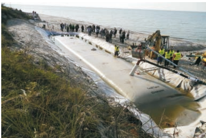
Rys. 14. Napelnianie georury SoilTain® w trakcie pokazu technicznego
