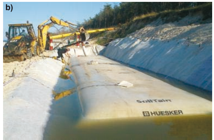
Rys. 12. Etap I: ułożenie płaszcza georury w wykopie (a) i napelnianie pierwszej georury mieszaniną wody i piasku (b)
