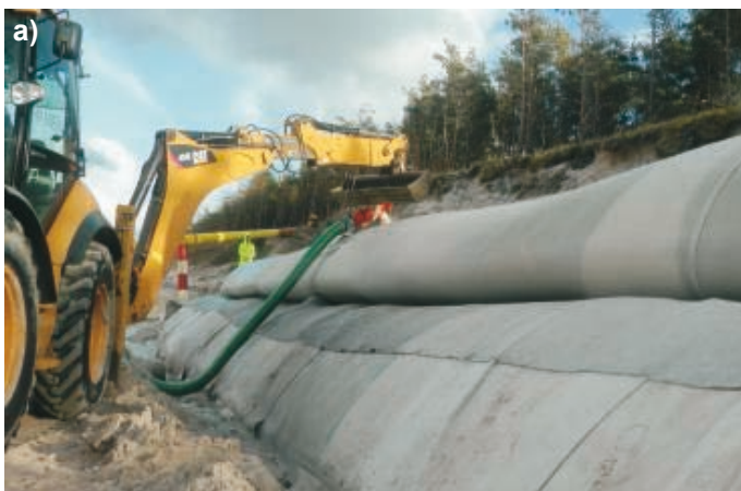
Rys. 13. Etap II: napelnianie drugiej georury mieszaniną wody i piasku (a) i zabezpieczenie georur SoilTain® geowłókniną ochronną (b)
