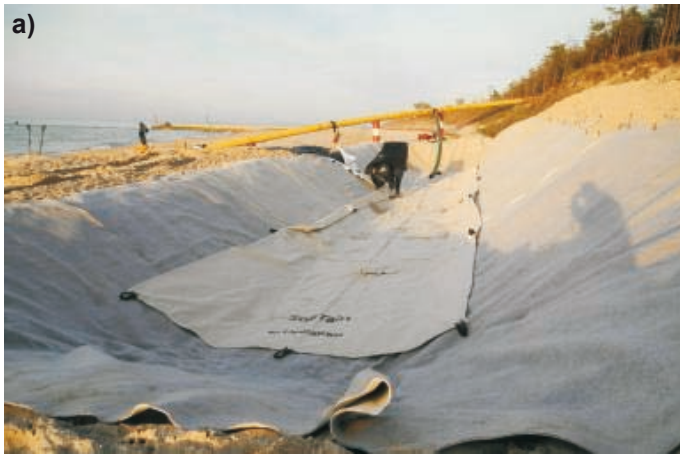
Rys. 12. Etap I: ułożenie płaszcza georury w wykopie (a) i napelnianie pierwszej georury mieszaniną wody i piasku (b)
